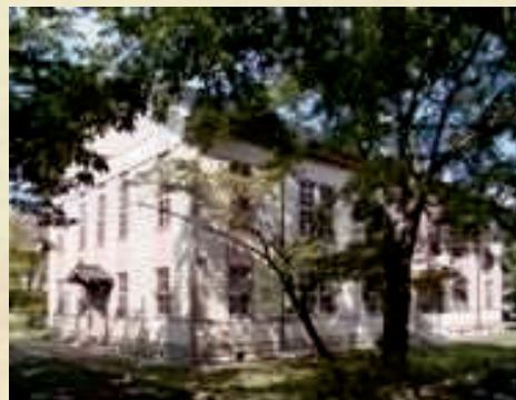
東南面からの外観
